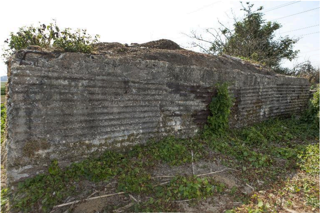
Élévation nord-ouest, vers le sud (coté front)
