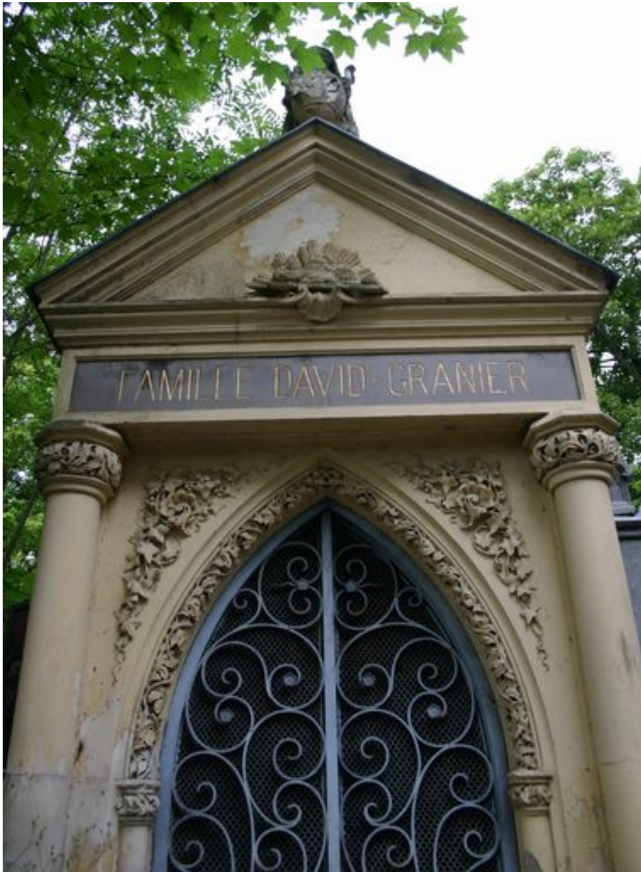
Façade principale du tombeau-chapelle (partie supérieure).
