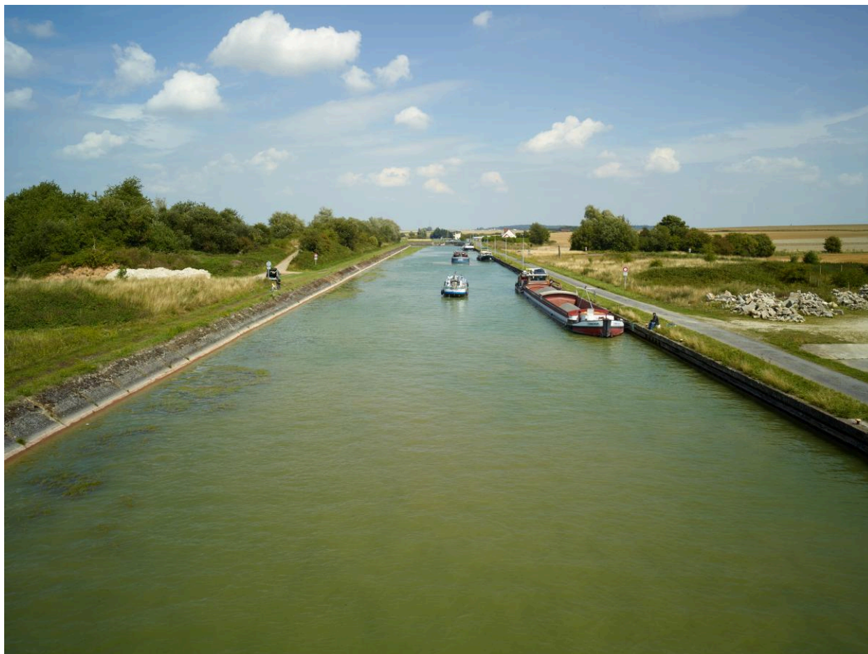
Havrincourt (Pas-de-Calais). Canal du Nord. Quai d'un ancien site de stockage de céréales.
