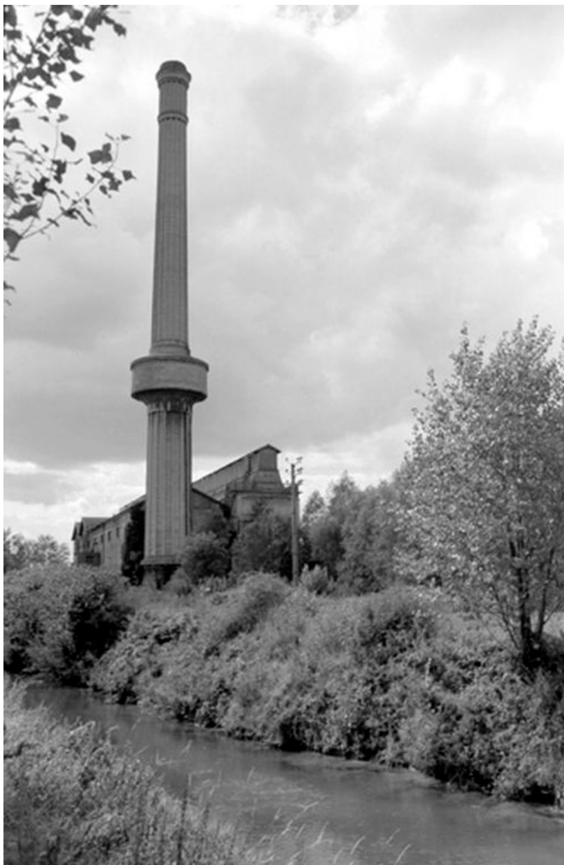
Cheminée d'usine, en 1988.
