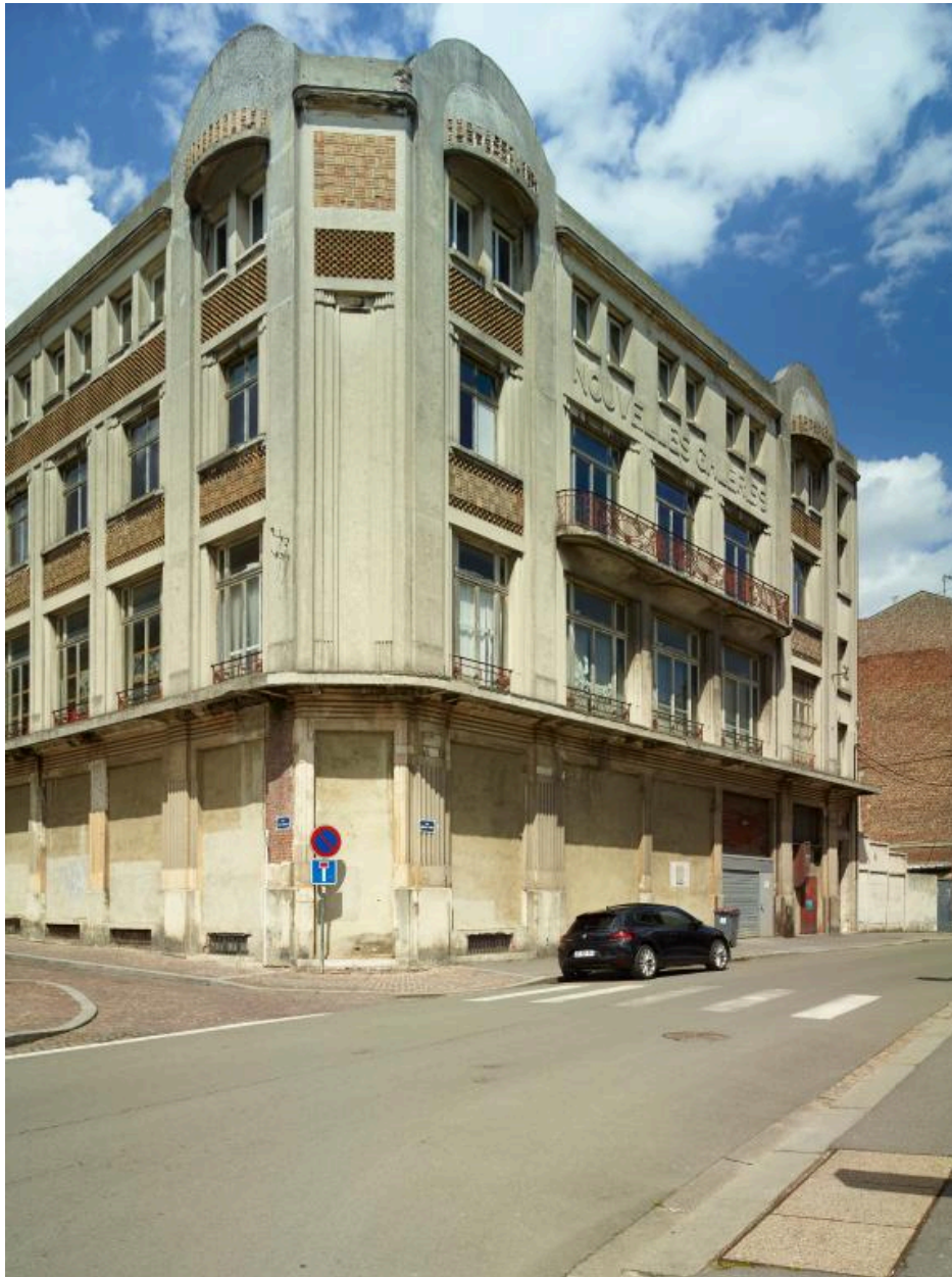
Façade sud des Nouvelles Galeries donnant sur la rue Anatole France, vue de trois-quarts depuis le sud-ouest.
