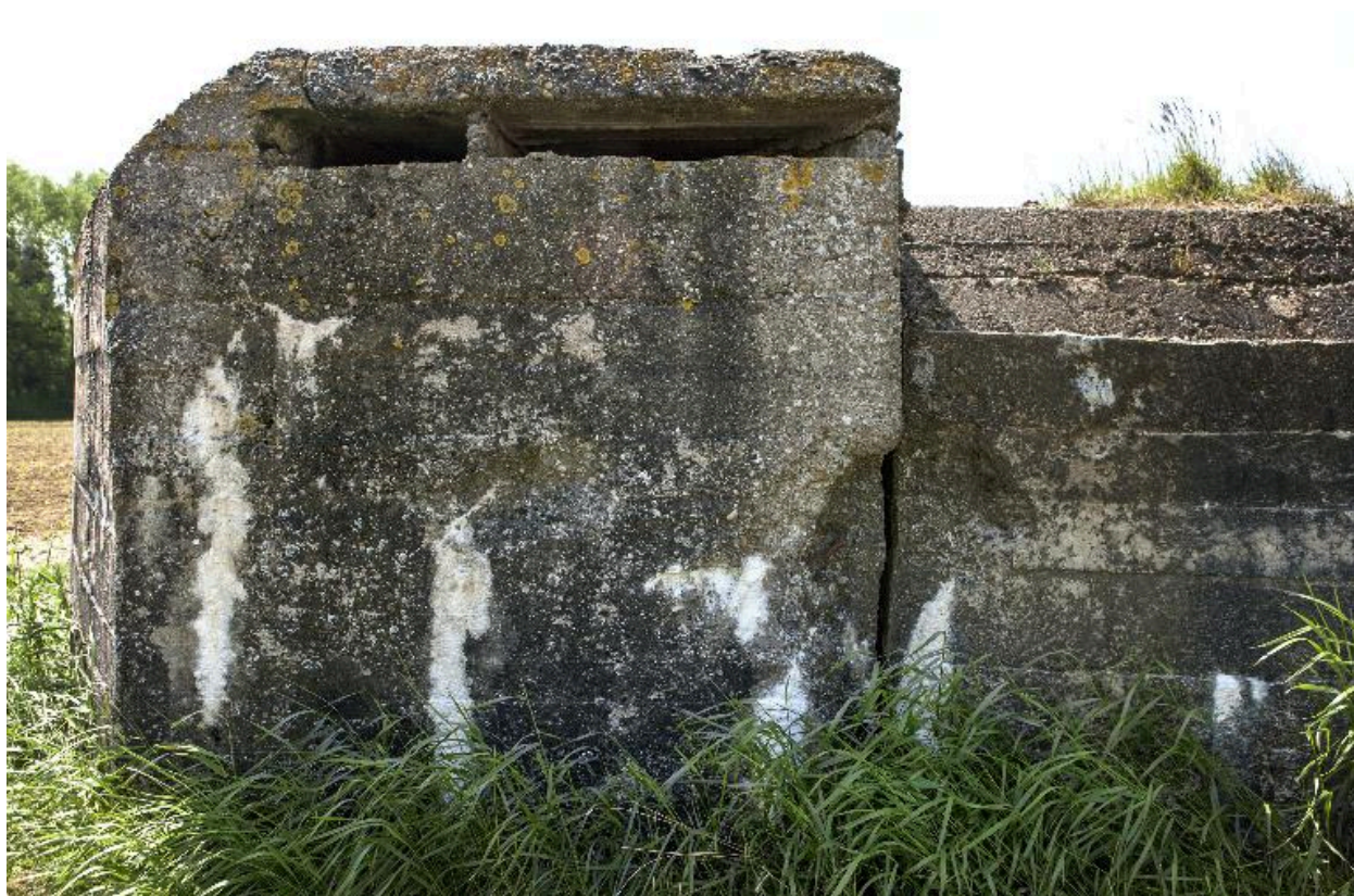
Arrière de l'observatoire casematé
