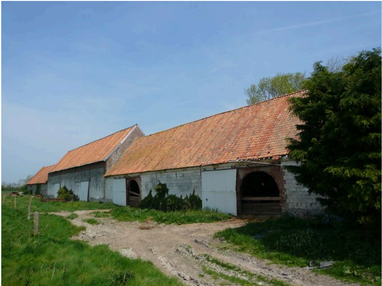
Vue postérieure des étables et de la grange situées à l'ouest de la cour.
