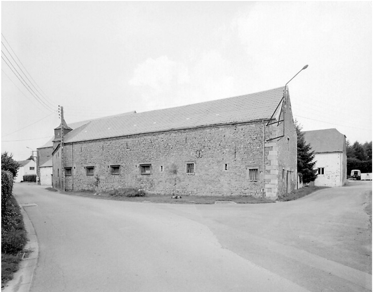
Vue des étables-fenil depuis la rue de l'Hôpital.
