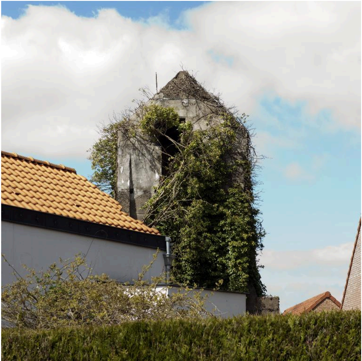
Tour casematée depuis la rue
