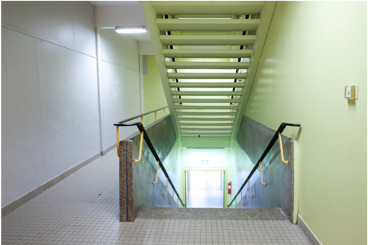
Escalier intérieur externat (lycée puis collège), 1er étage, 2016 (détruit en 2016).
