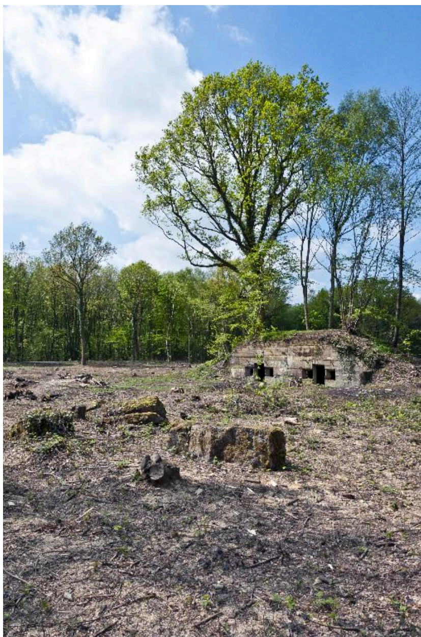
Vue générale vers l'ouest depuis le chemin du Bois du Biez
