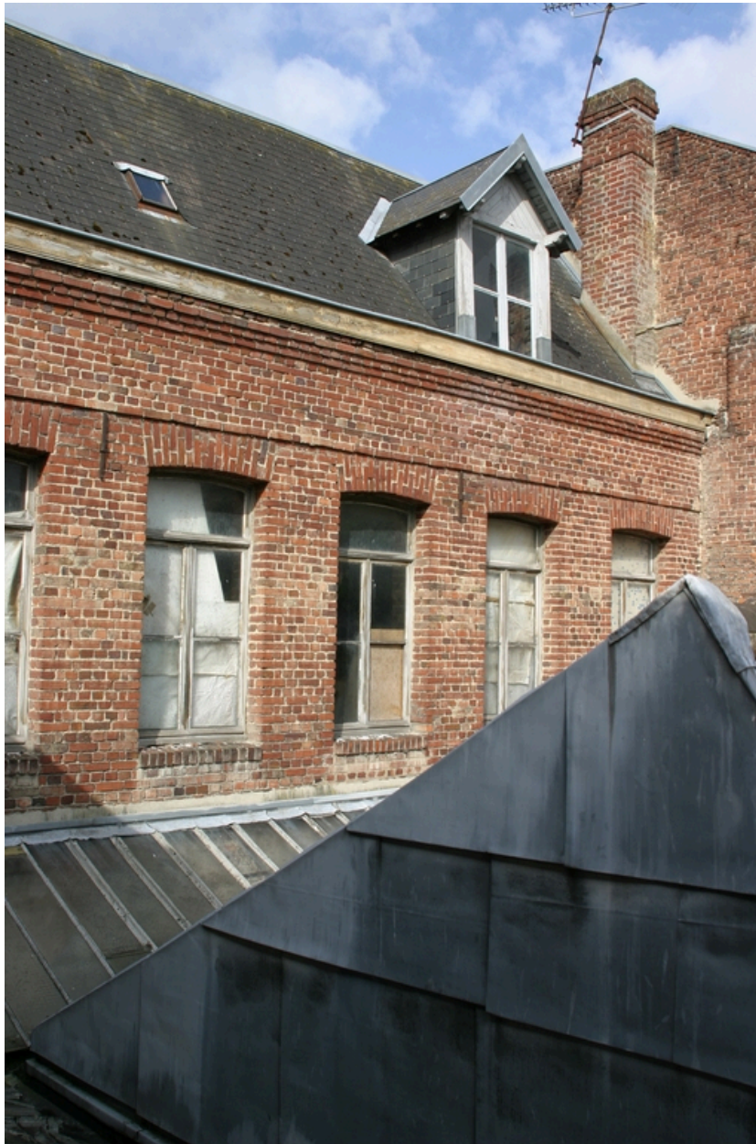
Façade postérieure des ateliers de la rue de Vesoul. Au premier plan, sheds de la cour intérieure.
