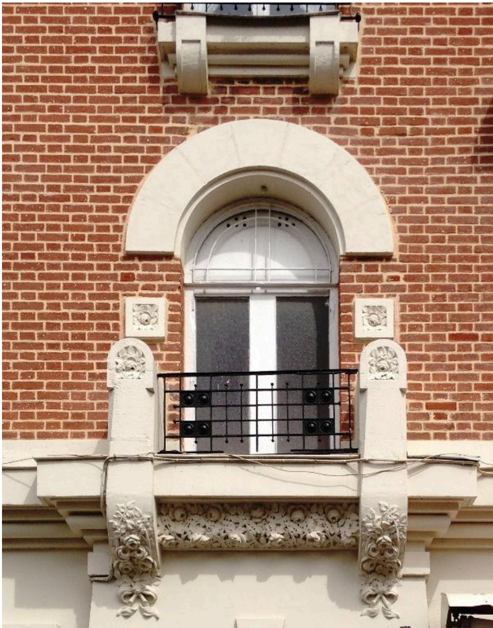
Détail d'une baie de la façade sur rue.
