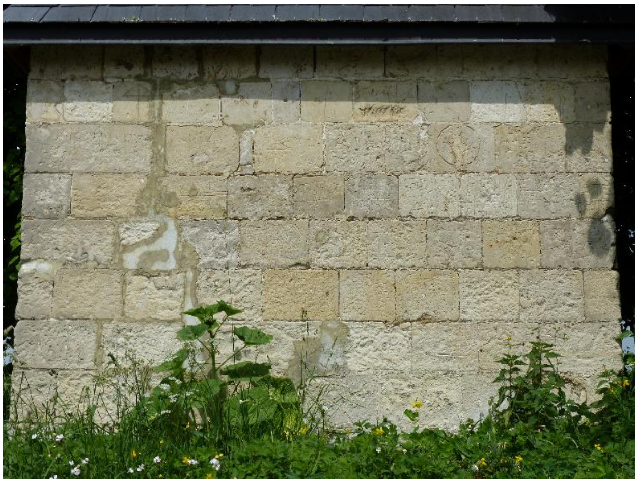
Vue du mur sud.
