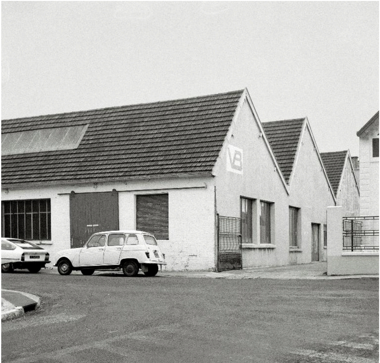
Vue partielle des ateliers de fabrication.
