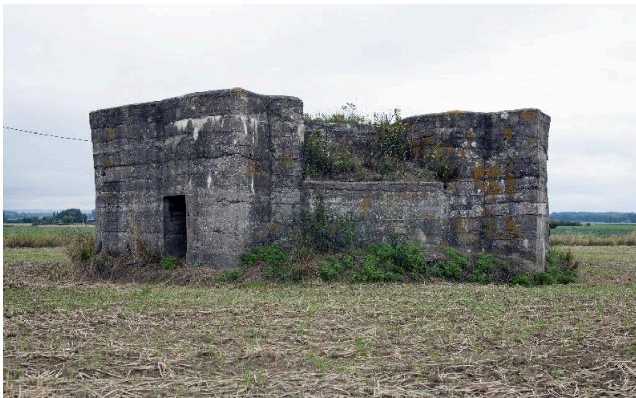
Vue de trois-quarts vers l'ouest. Entrée est
