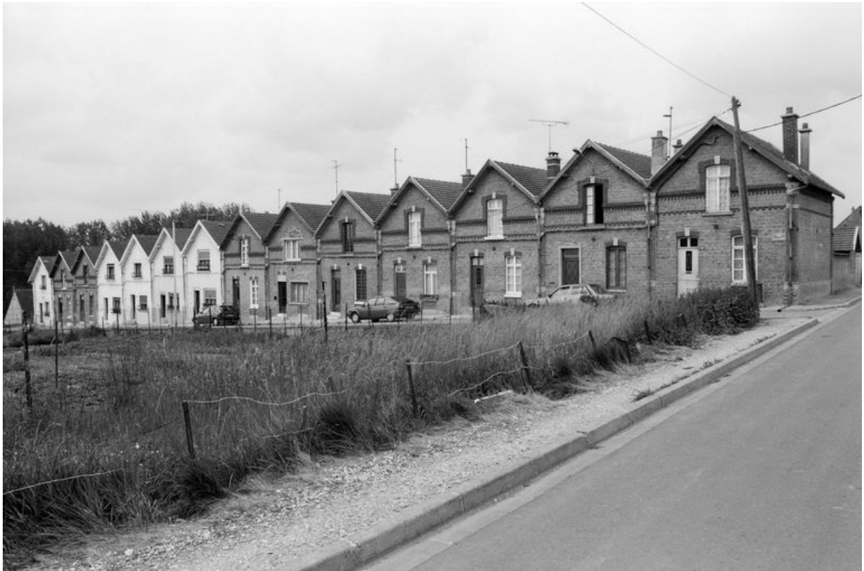
Vue d'ensemble de la cité Anthime Gigaut en 1991.
