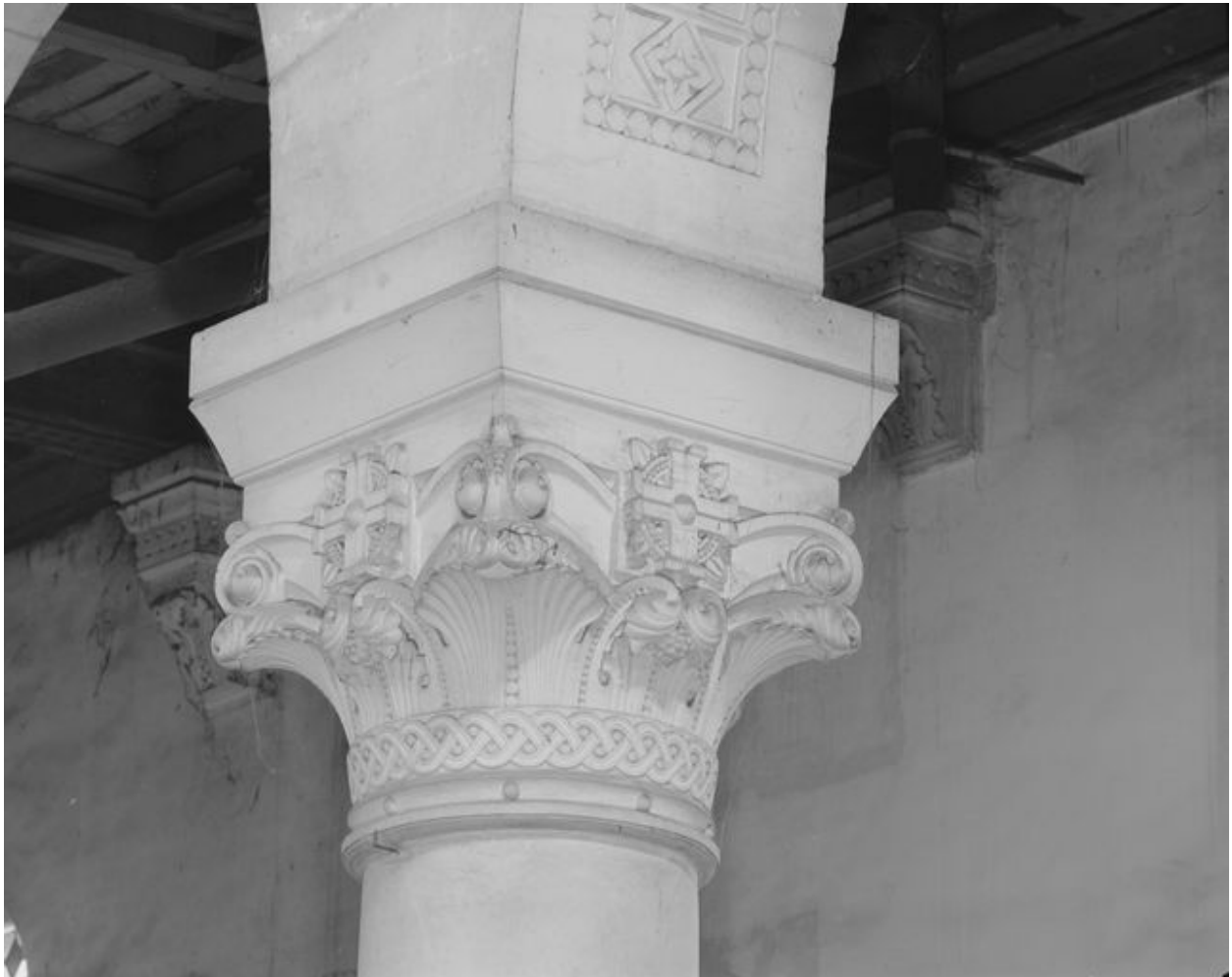
Vue de détail : chapiteau de la nef.
