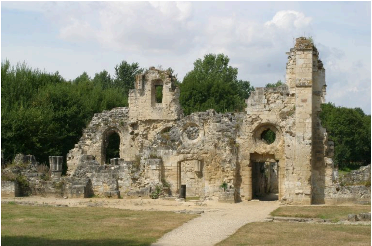
Vue partielle du bâtiments des convers.
