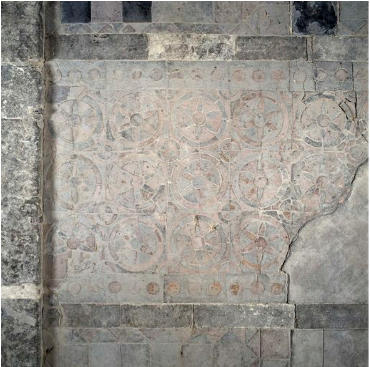
Détail du carrelage.
