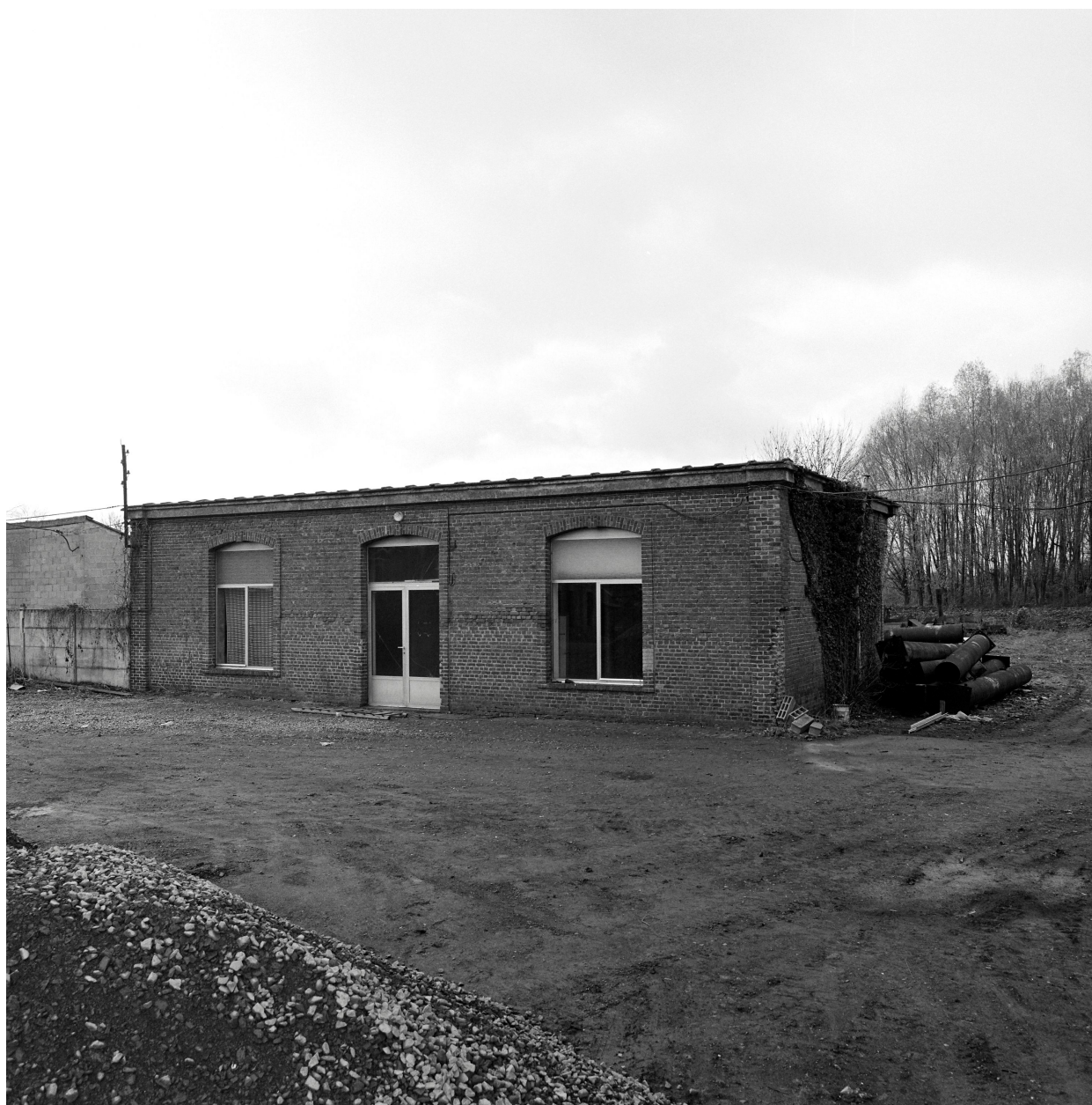
Entrepôt industriel (bâtiment F).
