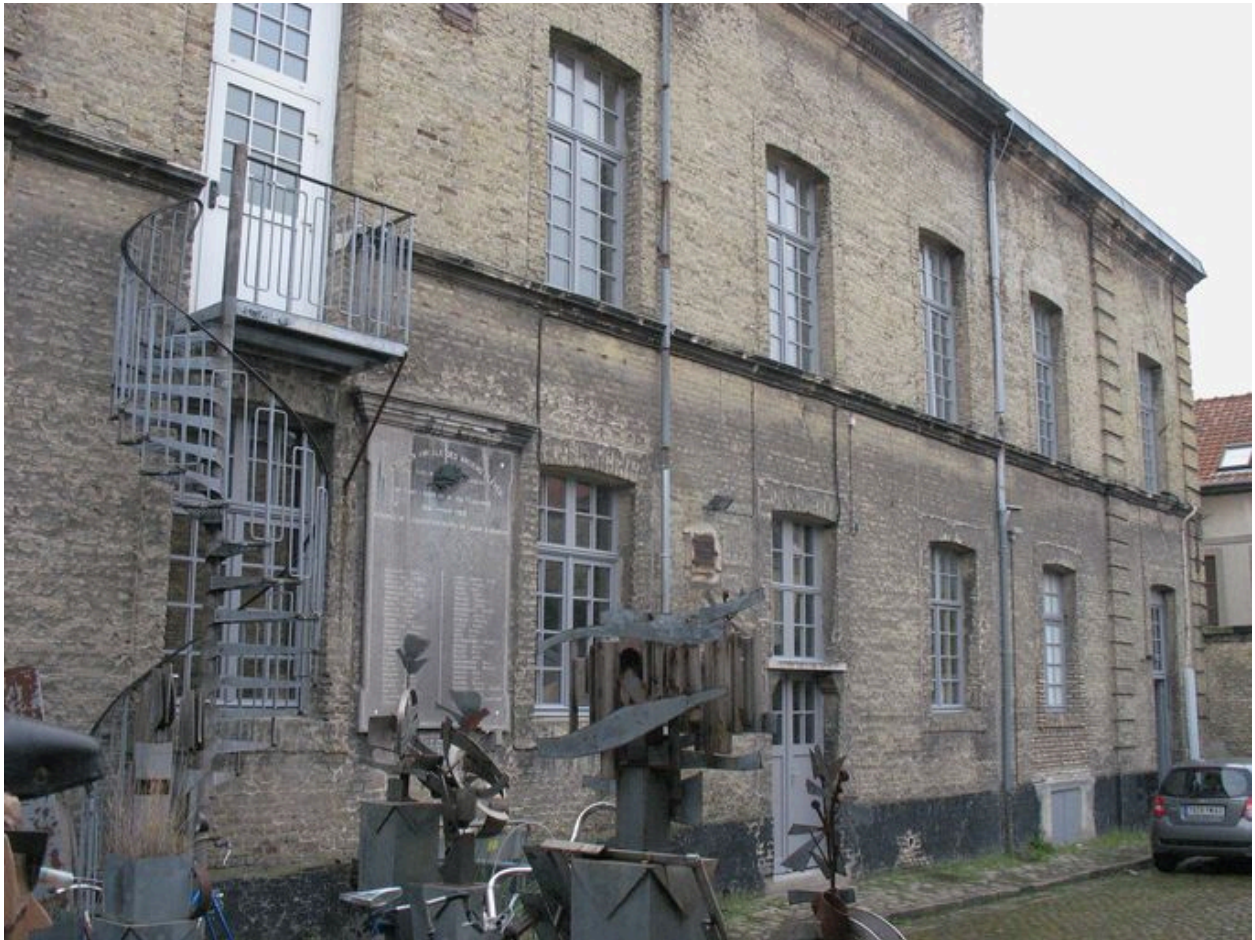
Façade sur cour
