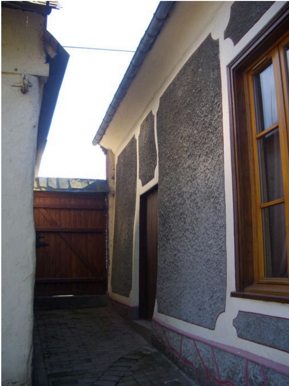
Vue du passage longeant le logis menant à la Grande Rue.
