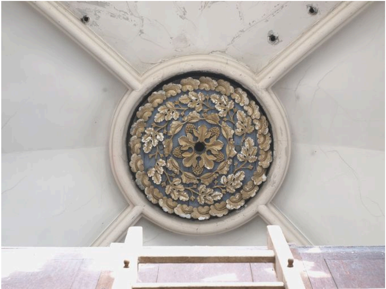
Trou de montée de cloche à l'étage de la tribune (ouest) obturé par une trappe en bois sculptée de motifs végétaux
