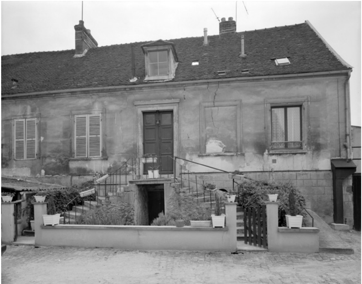
Vue de la façade principale sur cour.
