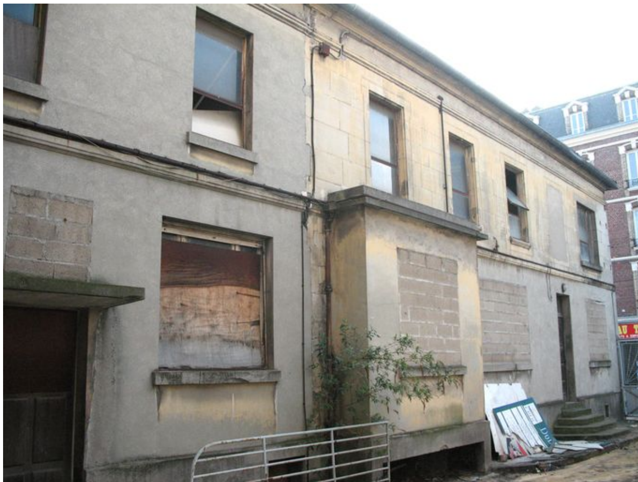
Les bureaux encadrant l'entrée des entrepôts.
