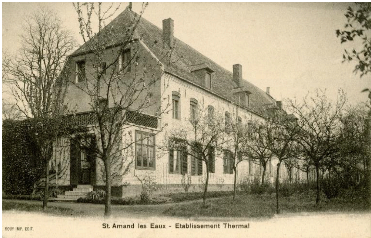
Vue générale arrière du grand hôtel, carte postale (Médiathèque Saint-Amand-les-Eaux).
