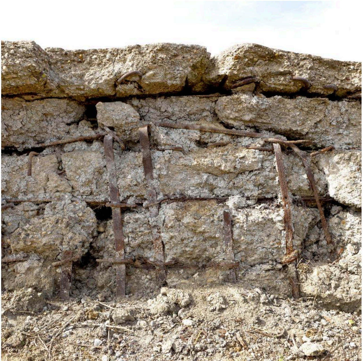
Elévation est, détail
