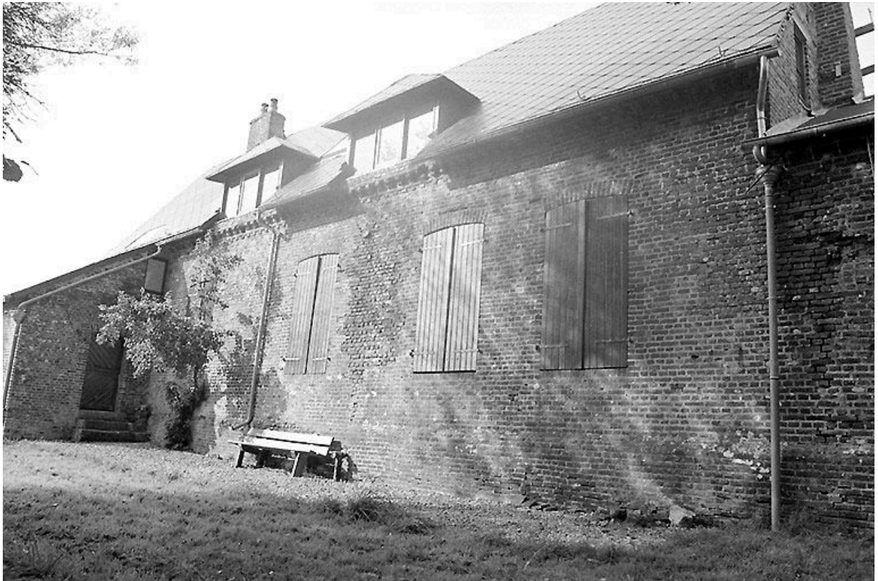
Façade postérieure du logis.
