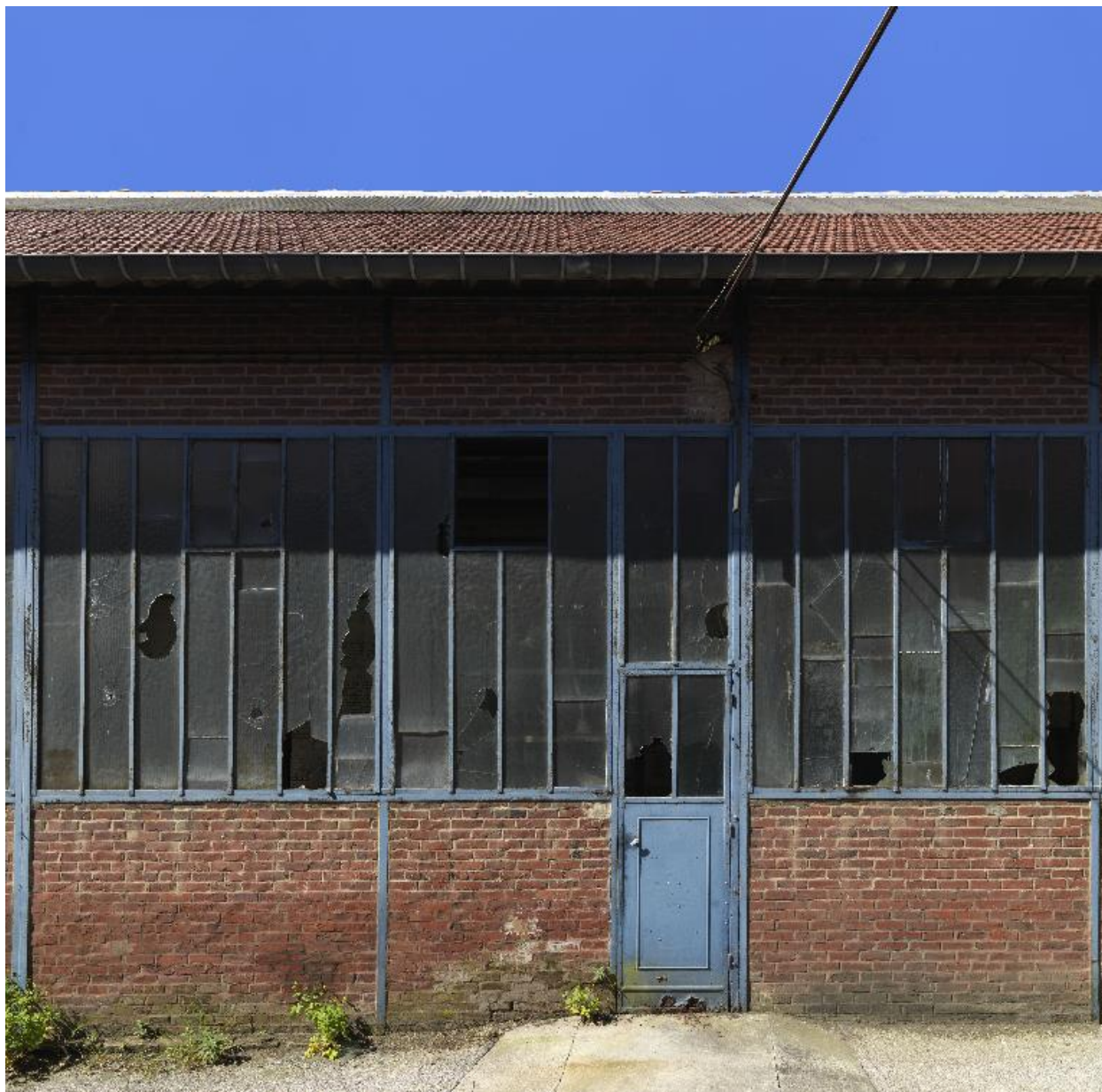
Détail des ouvertures de l'atelier de fabrication.
