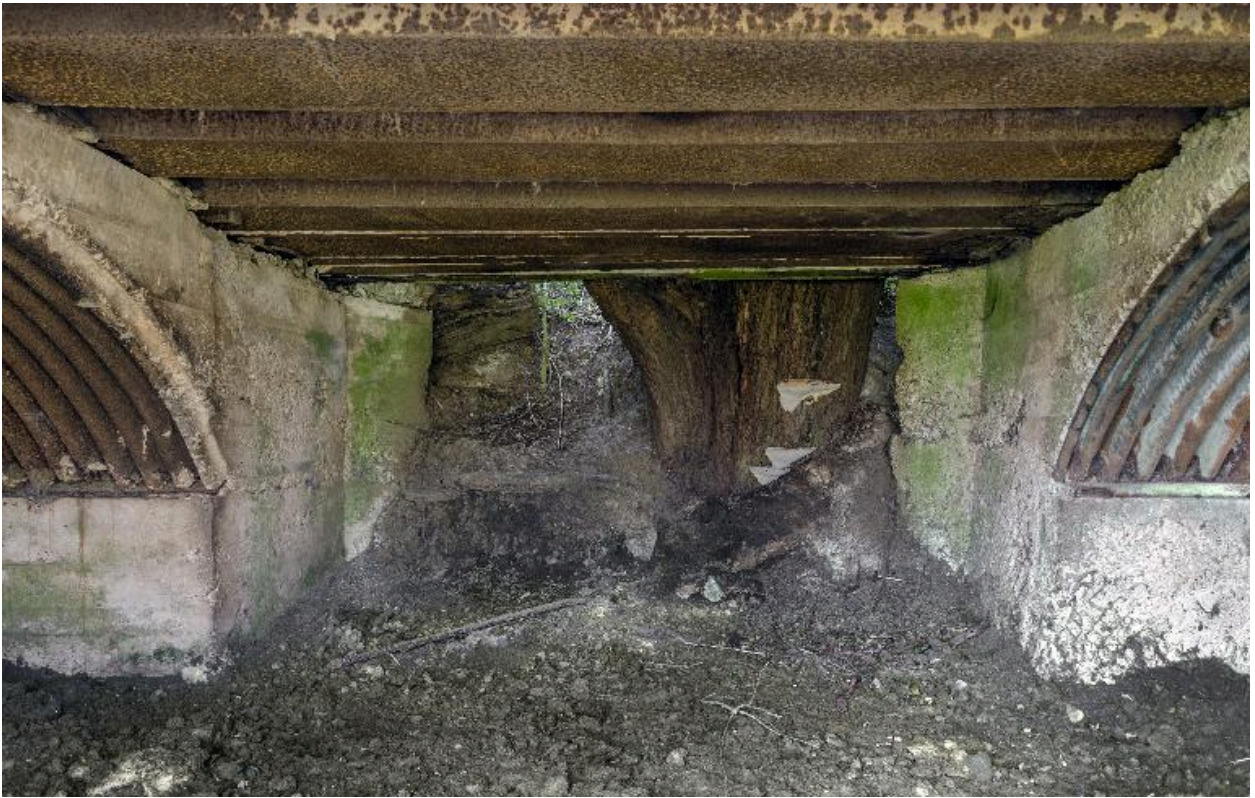
Intérieure de la chambre de tir, vers le nord
