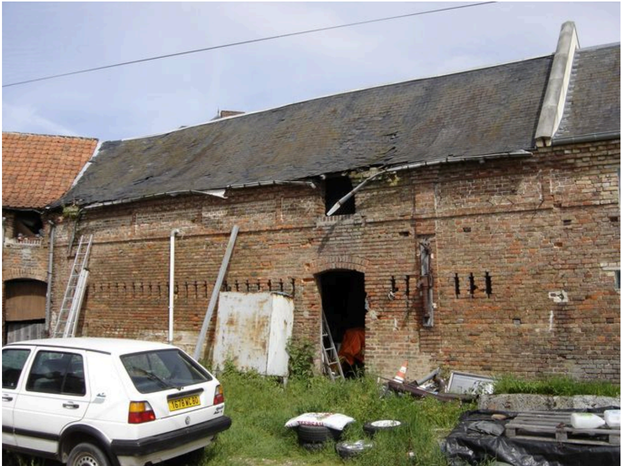
Vue des étables dans le prolongement des premiers éléments agricoles.
