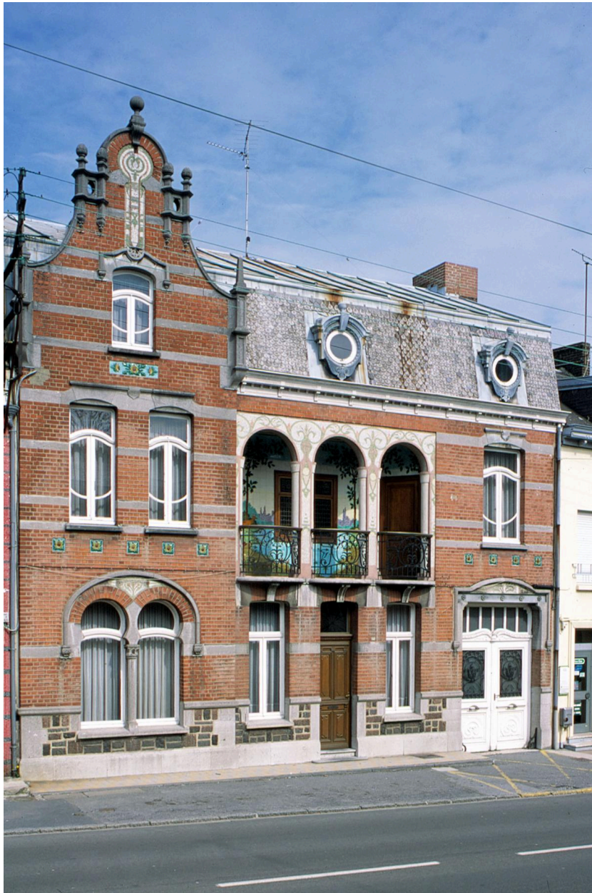
Vue générale de l'élévation antérieure.
