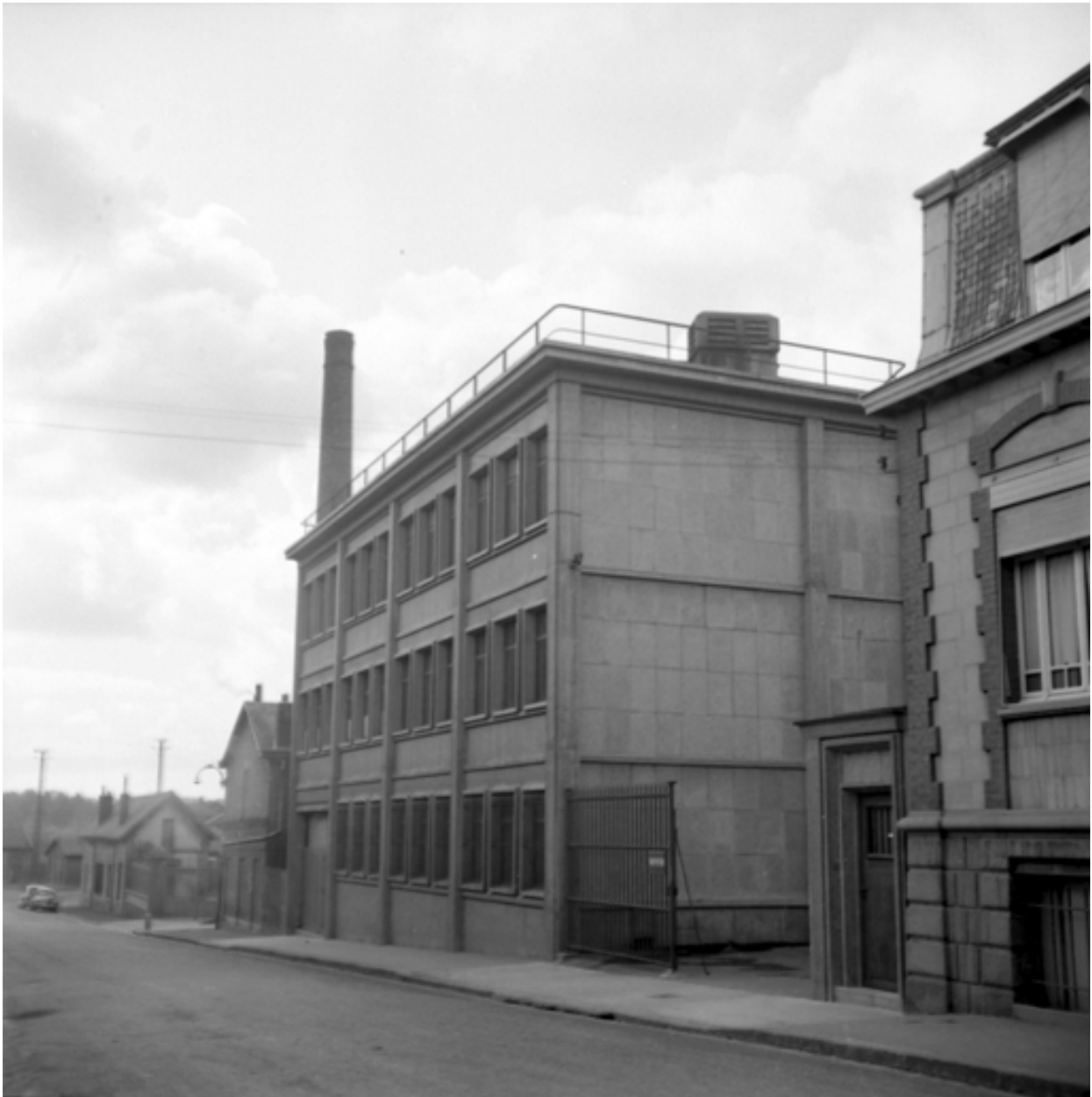
La chaufferie achevée, vers 1950 (IFA).
