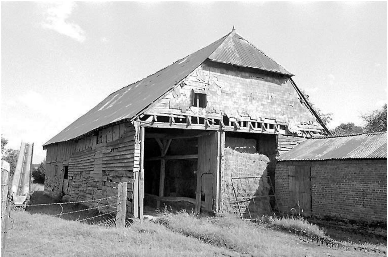
Grange vue depuis le nord-est et porcherie attenante.
