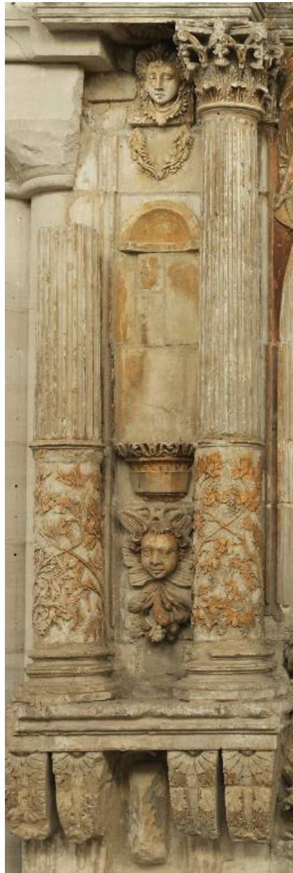
Colonnes jumelées de l'encadrement jouxtant un pilier du chœur.
