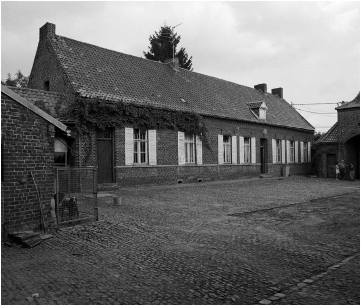
Vue générale du logis, 1036, rue de la Quièze.
