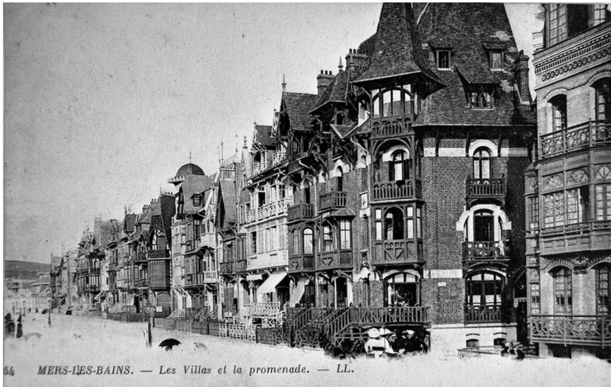
Les villas du lotissement depuis l'esplanade (îlot 22), carte postale, 1er quart 20e siècle (coll. part.).
