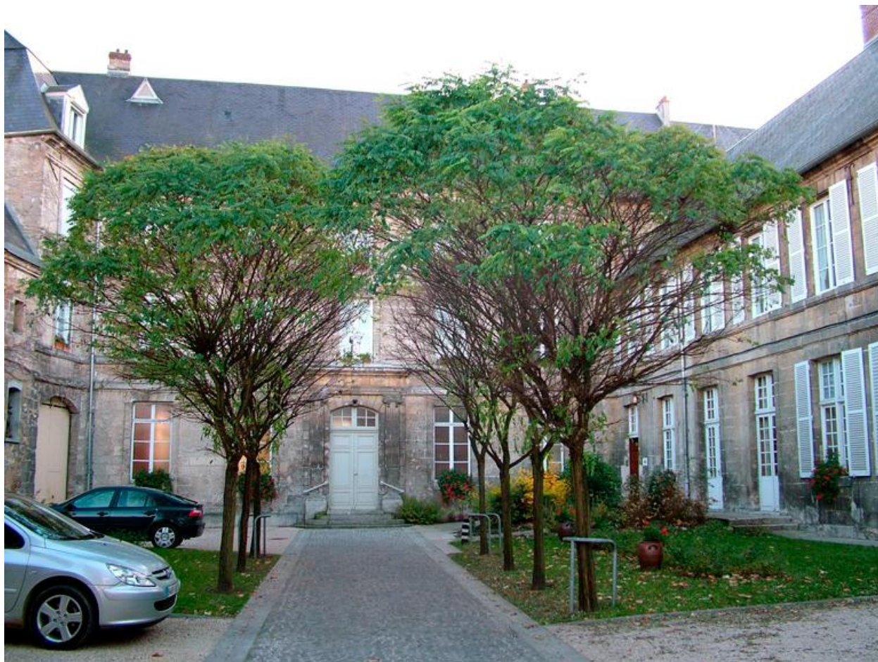
Vue partielle du logis prieural sur cour.
