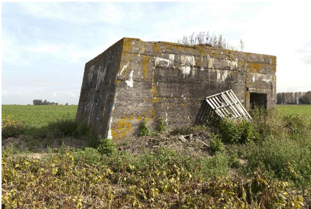
Vue vers le nord-est
