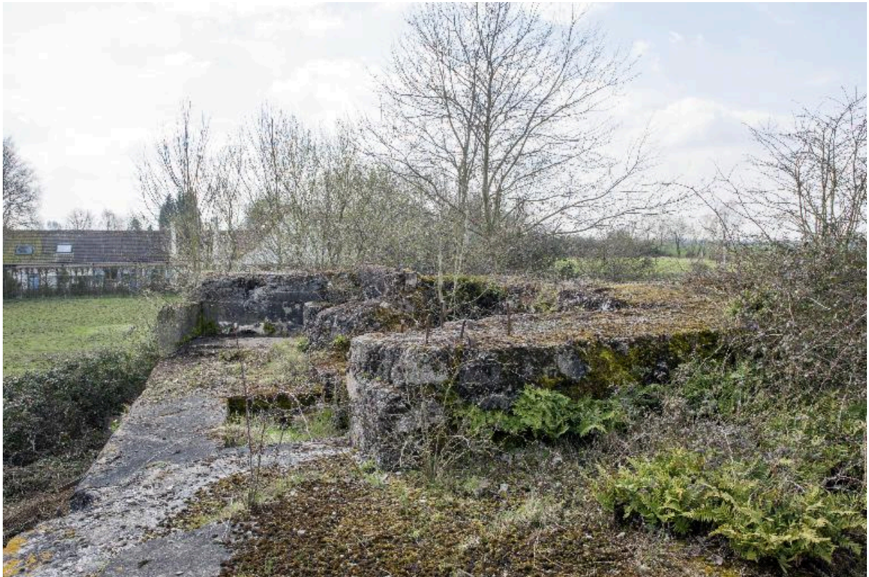
Casemate A: Dsepuis le couverture, vers le sud-ouest
