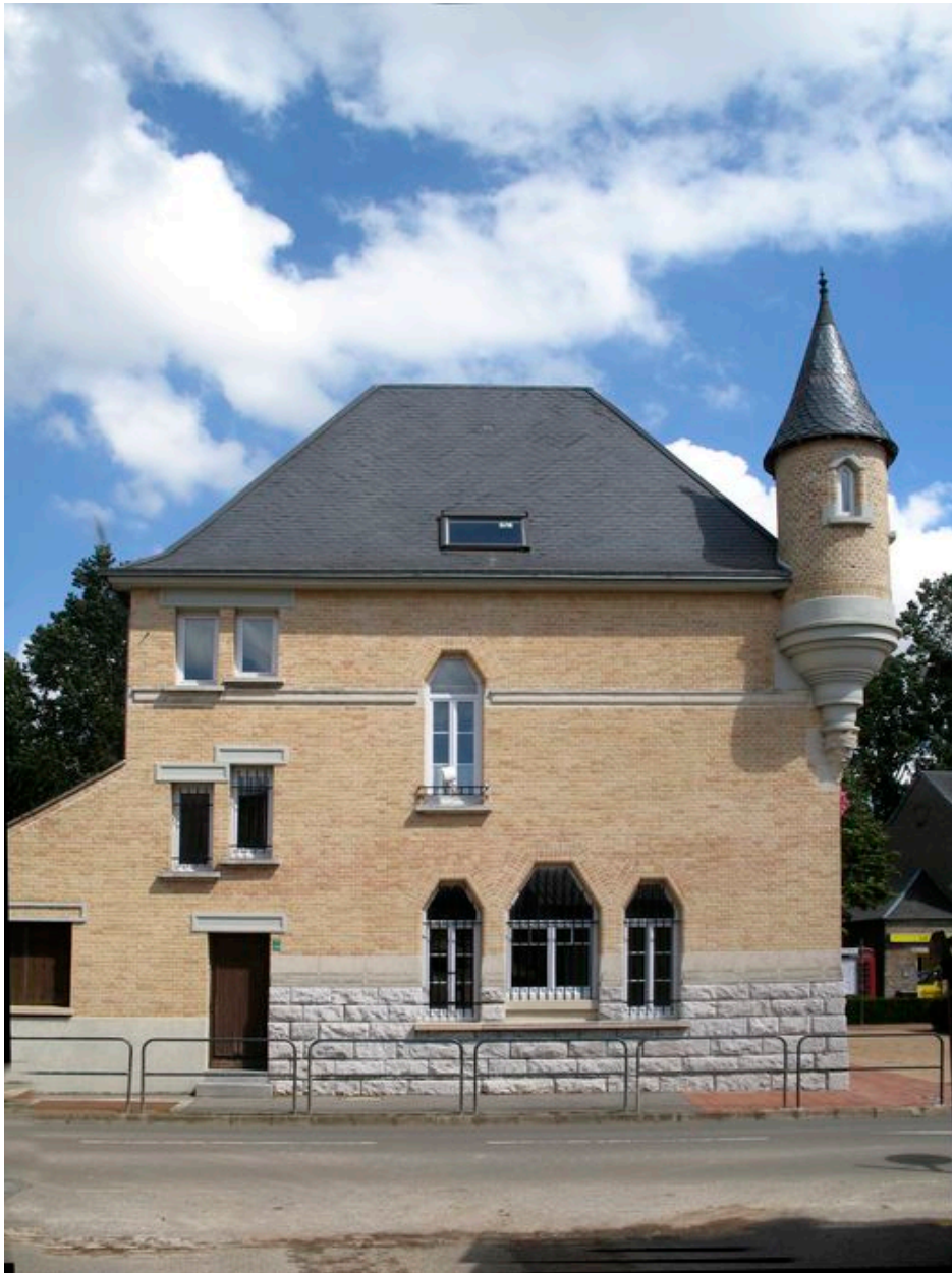
Elévation latérale sud.
