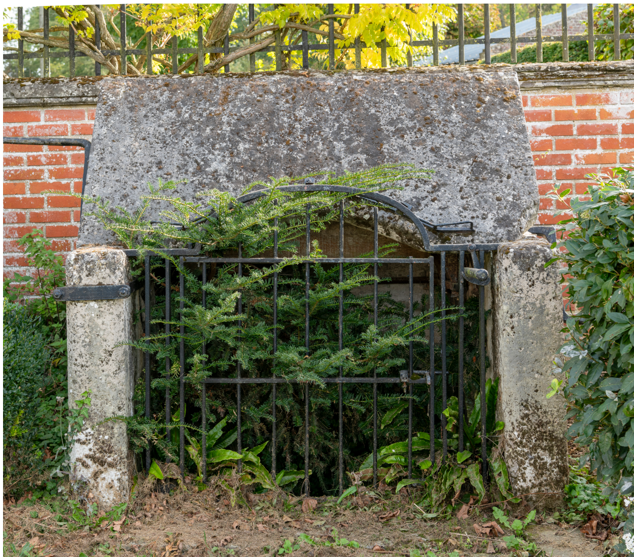
Ancien puits communal près de la place publique, vue depuis l'ouest.
