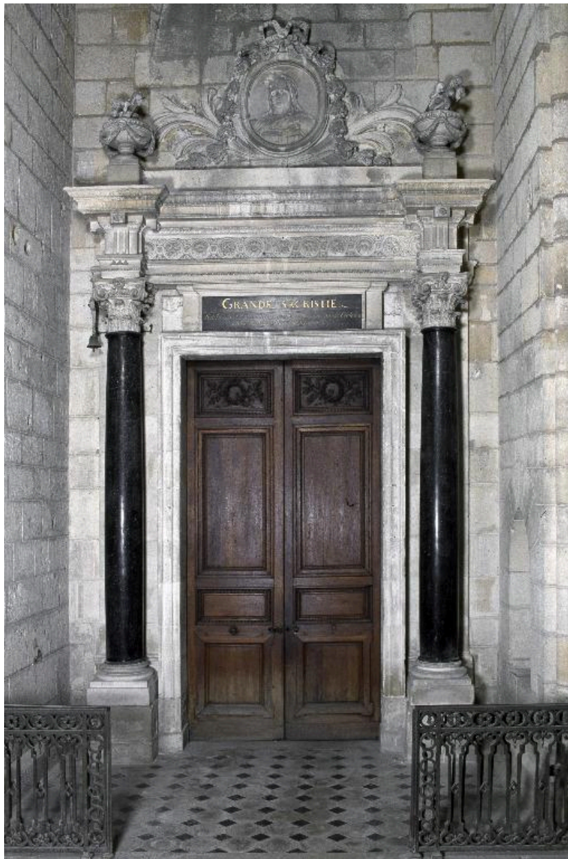
Vue générale de la porte.
