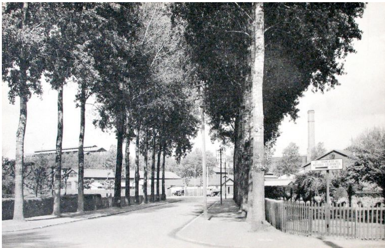
Entrée de l'usine chimique, vers 1930 (AC Villers-Saint-Paul ; fonds local).
