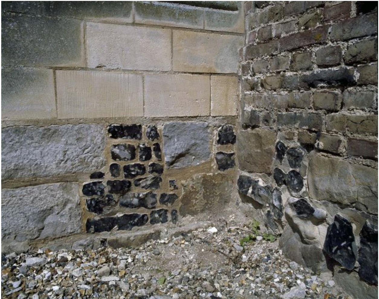
Détail de l'appareil de la base du mur du clocher.
