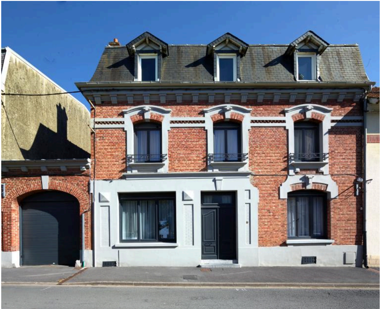
Vue générale de la façade depuis la place Faidherbe.
