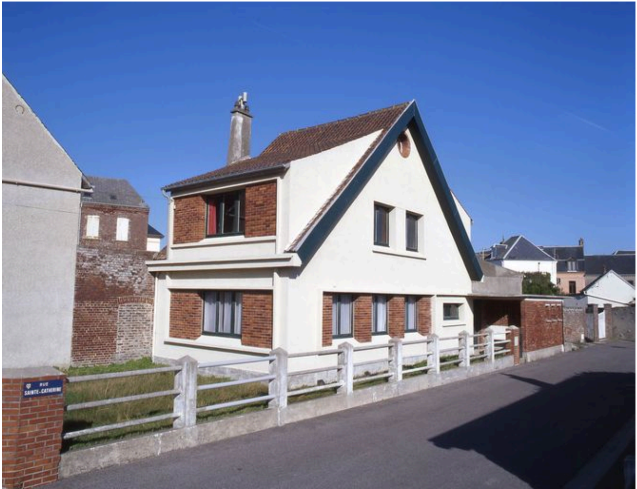
Vue d'ensemble depuis la rue du Maréchal-Joffre.
