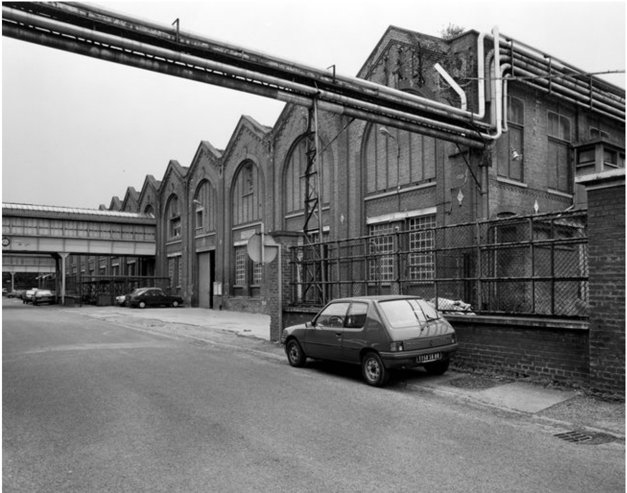
Façade sur rue de l'ancienne bâcherie, état en 1988.
