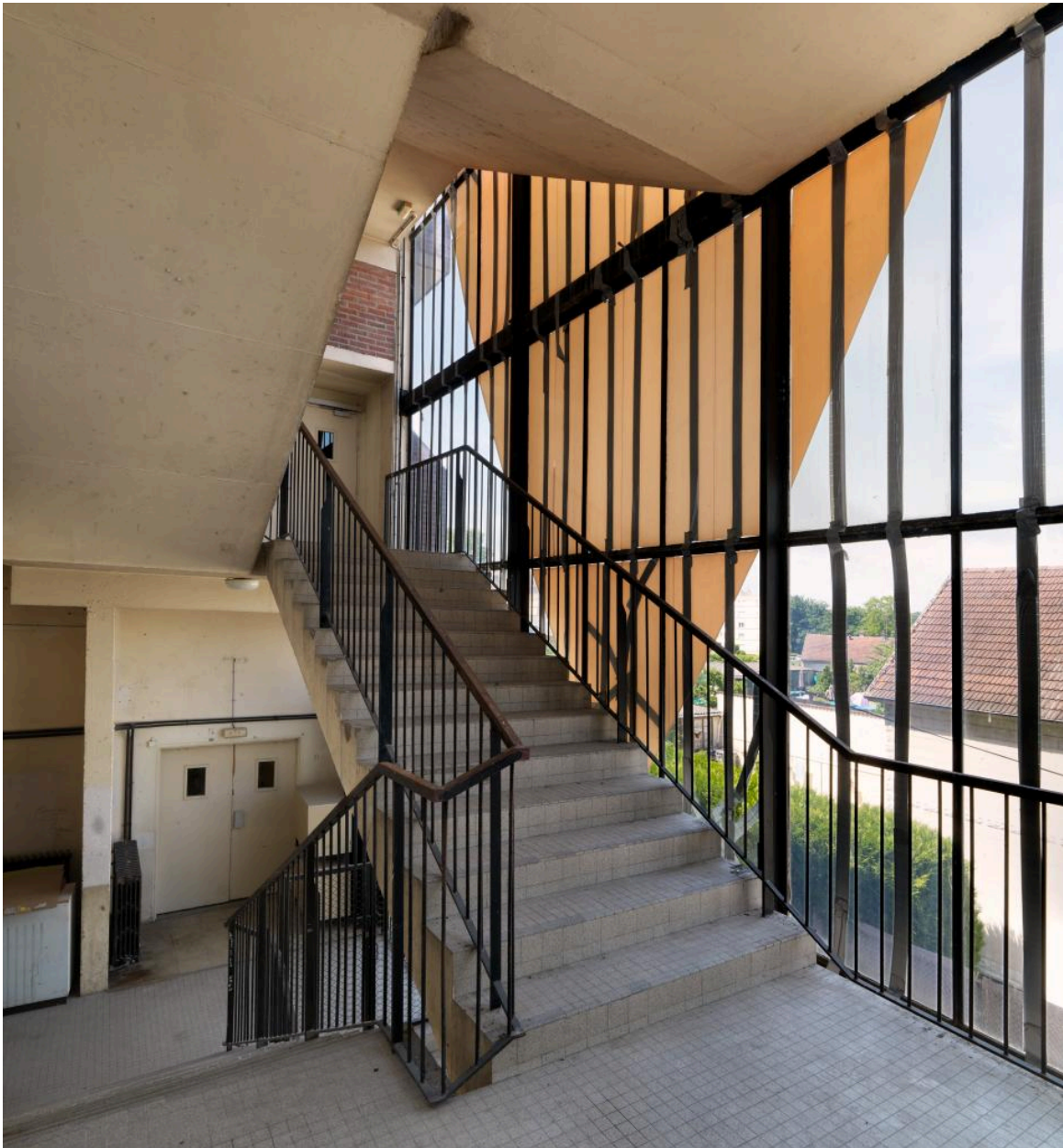
Vue intérieure de l'escalier.
